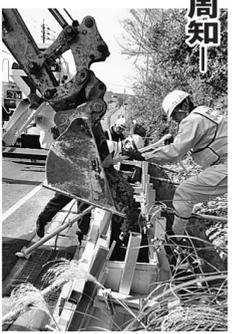
1月に行われたパイロット工事での砕砂生コン打設の様子
